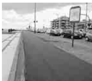
LAVORI SUL LUNGOMARE DI CATANIA
